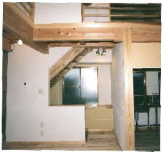
建主様が仕上げた内壁（珪藻土使用）
