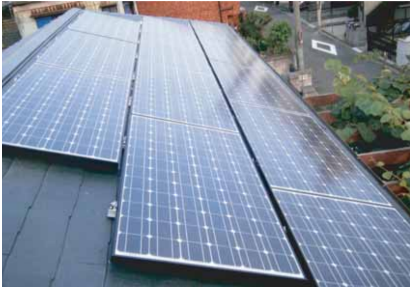
太陽光発電取付現場
